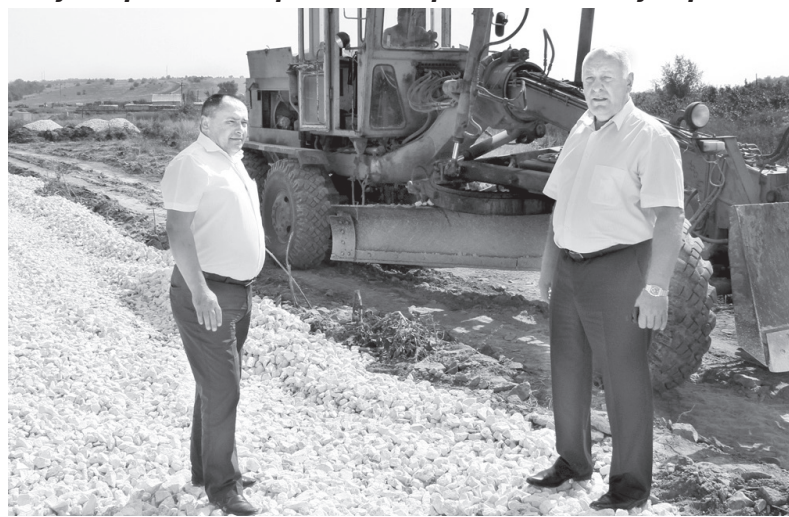
С.В. Пономарев и Н.Н. Свиридов проверяют ход дорожных работ.
